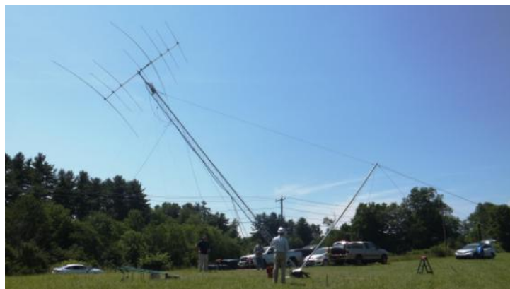
Het oprichten een van de vele masten in volle gang
